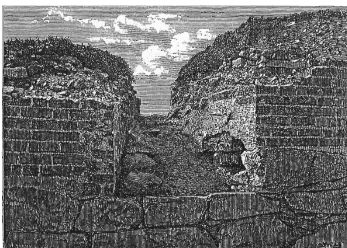
Bild 23. Fönsteröppning i den nordöstra sidan innan den fått förfalla. Fönstret på den södra mursidan såg säkerligen ut på ett liknande sätt. Alla fönster i borgen har en liten glugg utåt och en vidare inåt. Sett från sydväst (Berg 1883: 53).
